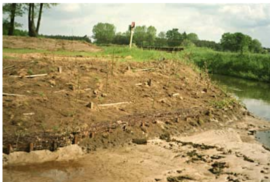
Weidenspreitlagen zur Ufersicherung direkt nach der Fertigstellung
