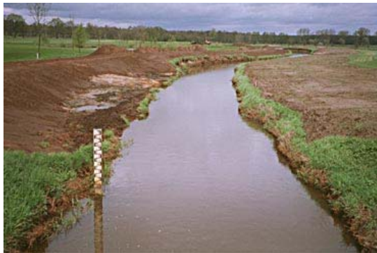
Aufweitung und Flachwasserzone am unteren Ende des Bauabschnittes kurz nach Fertigstellung
