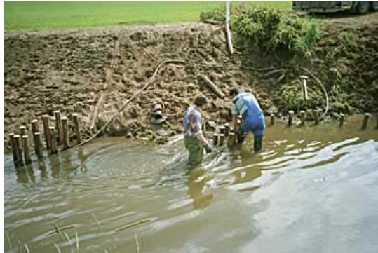
Einbau von Strömungslenkern (hier doppellagige Faschinen)
