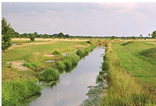
Umgestaltete Wietze nach einer Vegetationsperiode (links Nassbermen, rechts Unterhaltungstreifen) bei einem kleinen Hochwasser
