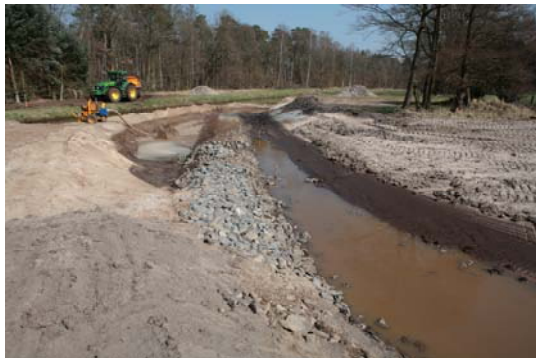
Sandfang im Nebenschluss (Im Bau)
