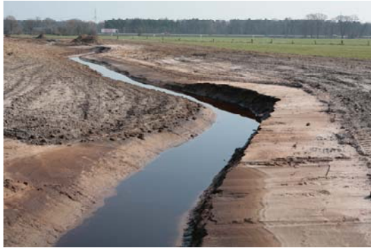
Vorprofilierung der neuen Gewässertrasse
