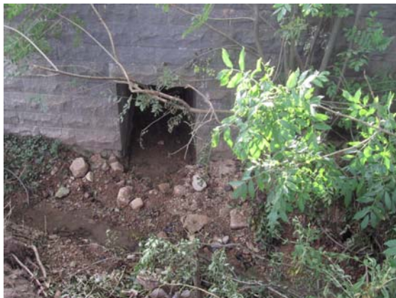
Gemauerter Straßendurchlass (Blickrichtung stromabwärts) nach dem Bau
