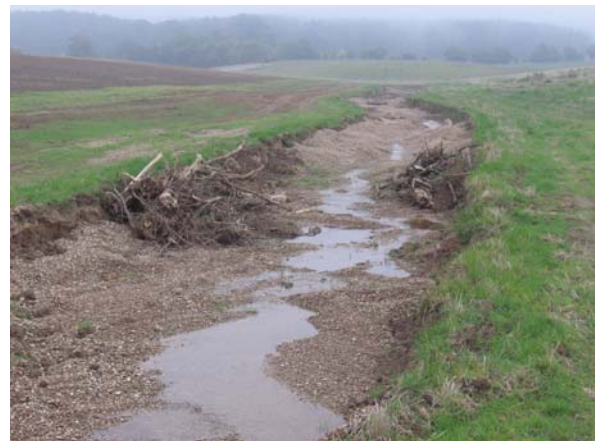
Vorprofiliertes Bachbett mit Kiesschüttung und Totholz
