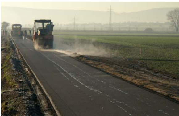
Wegeausbau, Herstellen einer Asphalttragdeckschicht
