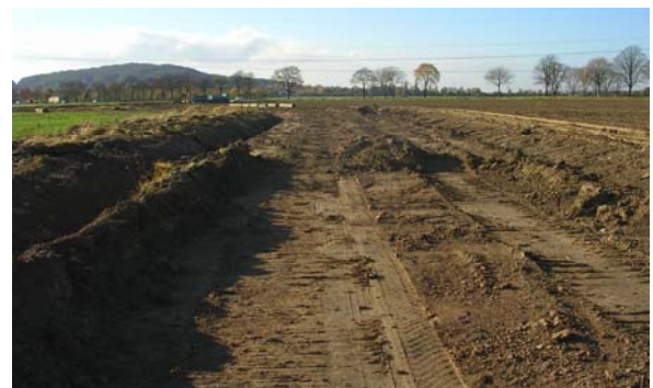
Erdarbeiten zur Rekultivierung eines Weges zu Ackerfläche
