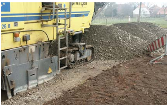
Einsatz einer Straßenfräse zur Aufbereitung von vorhandenen Schottertragschichten
