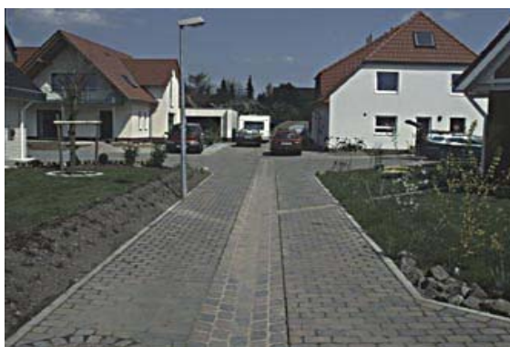
Regenwasserableitung in den Wohnstraßen in gepflasterten Rinnen
