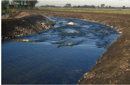
Sohlgleite (flussabwärts gesehen) unmittelbar nach der Fertigstellung
