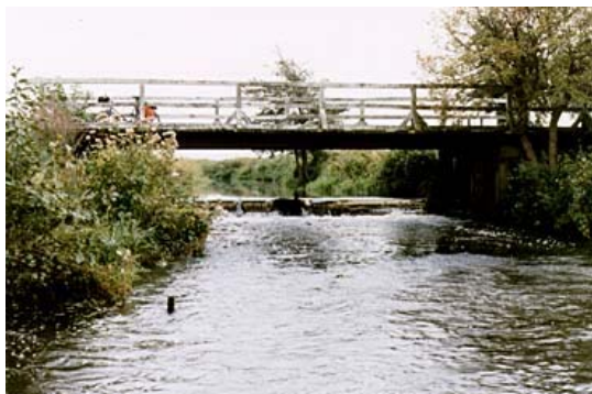
Schleuse 11 vor der Umgestaltung
