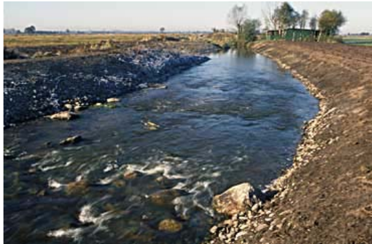
Fußbereich der Sohlgleite (Stromabwärts)
