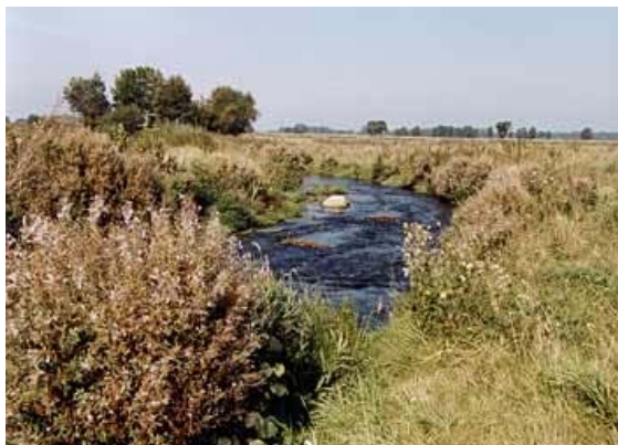
Sohlgleite zwei Jahre nach der Fertigstellung
